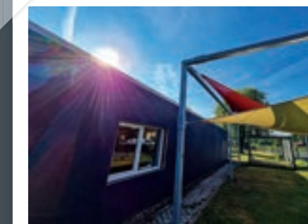
SPEZIALGEWEBE HÜLLT EINEN TEIL UNSERES GEBÄUDES. ES SCHÜTZT VOR WÄRME UND UV-STRAHLEN UND LÄSST LICHT INS INNERE.
